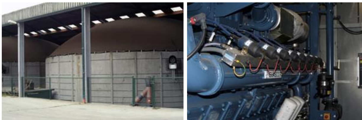
Figuur 60. De biogasinstallatie van Biofer bvba
