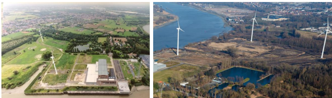
Figuur 28. Luchtfoto's van de site in Schelle met de oude windmolens van Electrabel. Deze zullen in 2021 afgebroken worden
