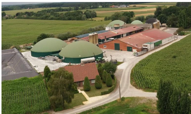
Figuur 45. Gebouwen en Biogasinstallatie op de site van Agro-Energiek
