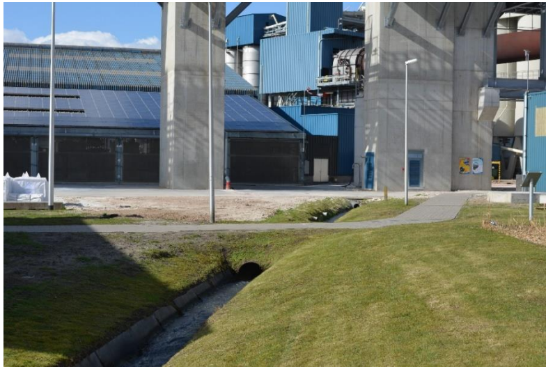
Figuur 5. Koelwaterreststroom bij Sibelco in Dessel met een continu debiet van 160m 3 /u aan 55°C 42
