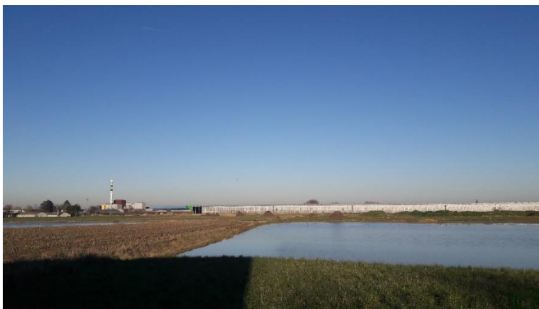
Figuur 63. Serrebouw Tomco vanuit de Kleine Mosstraat
